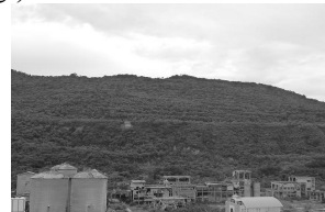
圖(十六)遠眺台泥高雄廠復育後的柴山地貌
